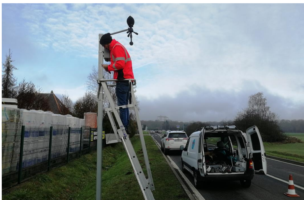
Installation d'un capteur méduse le long de la RD91 à Saint-Lambert-des-Bois
